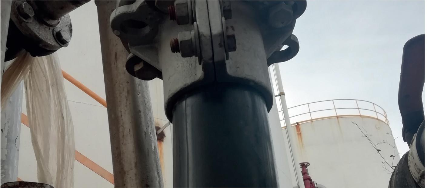
Instalación de tubería Pexgol en planta de producción de procesamiento de pescado.
