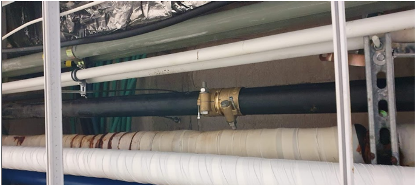
Instalación de tuberías Pexgol para suministro de agua potable de Cloro Libre.
